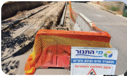
تغيير خط مياه الشرب الرئيسي-بقعاثا
