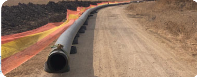
تحسين خط تجميع مياه الصرف الصحي - كتسرين
